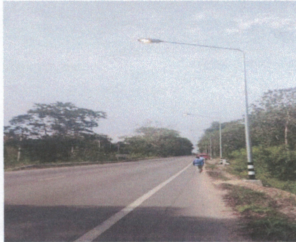
โครงการก่อสร้างถนนคอนกรีตเสริมเหล็ก ขอยทุ่งเสมอ หมู่ที่ 4
