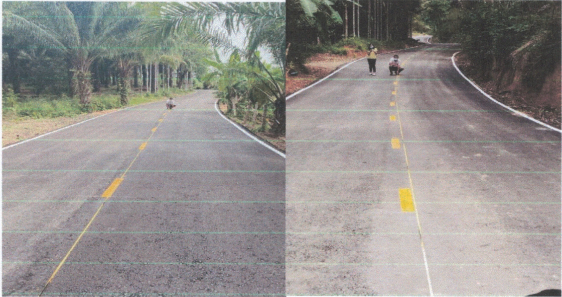
ก่อสร้างถนนพาราแอลฟัลต์ติก ซอยอ่าวท่าหิน หมู่ที่ 2
