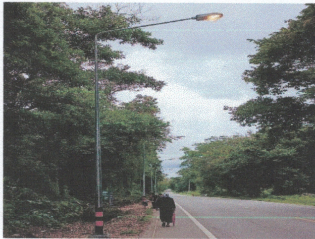
ต่อเติมไฟฟ้าสาธารณะริมถนนเพชรเกษม หมู่ที่ 1 (ช่วงต่อขยาย)
