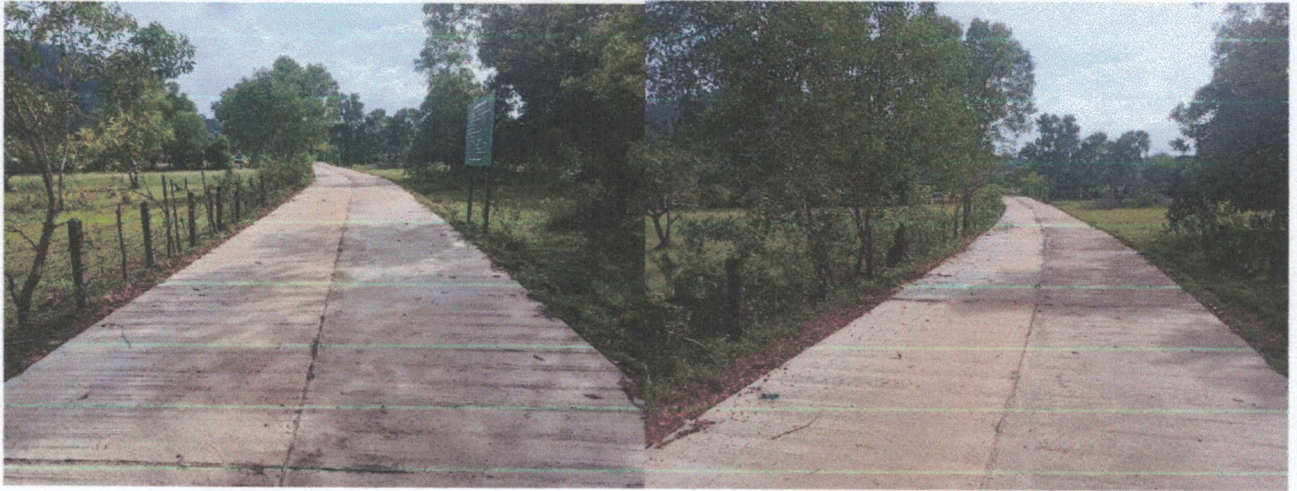
ก่อสร้างถนนคอนกรีตเสริมเหล็ก ซอยสวนสนุก หมู่ที่ 4
