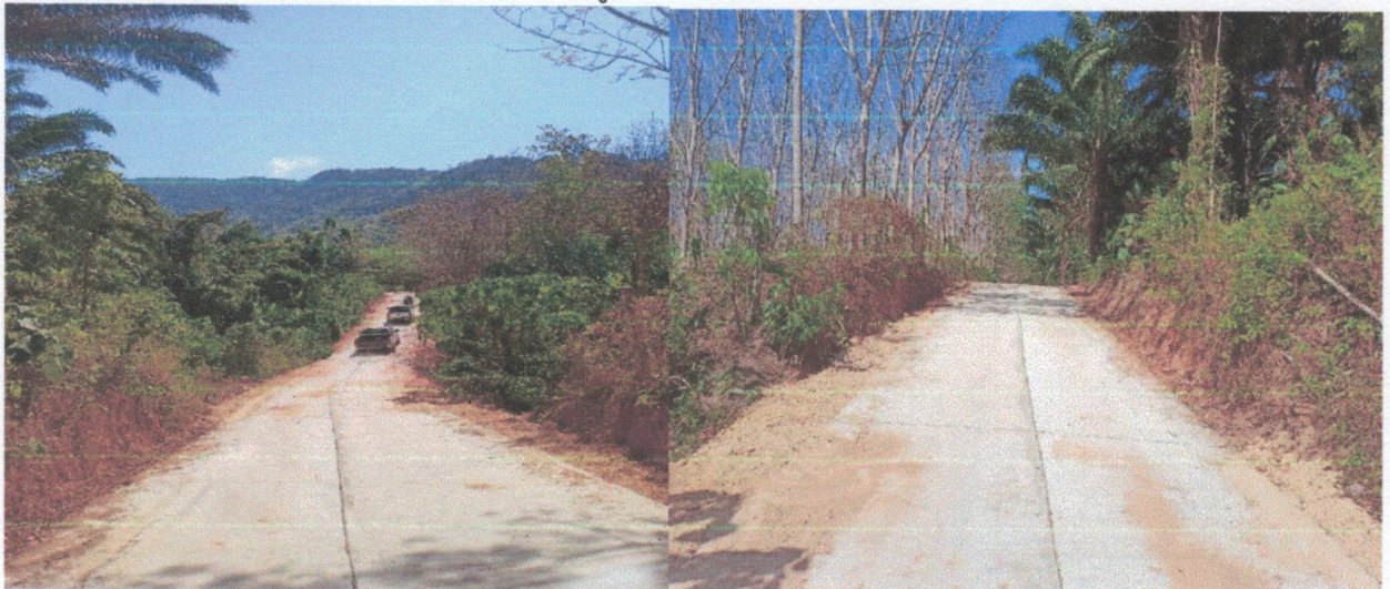
ก่อสร้างถนนคอนกรีตเสริมเหล็ก ซอยบ้านสวน หมู่ที่ 1
