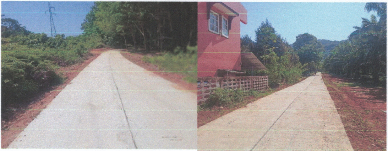
ก่อสร้างถนนคอนกรีตเสริมเหล็ก ซอยดอยร้อยวิว หมู่ที่ 3
